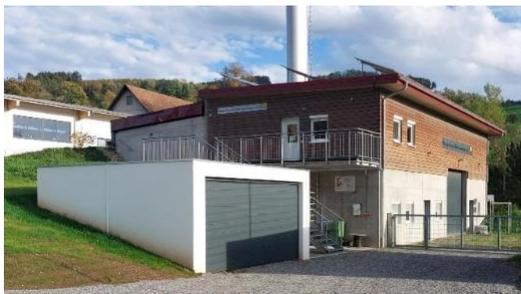
**Abbildung 1:** Das Heizhausgebäude mit Holzhackschnitzelbunker.
